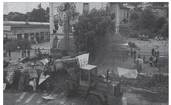
Les bulldozers en action, août 2000 © Chris Blazer
